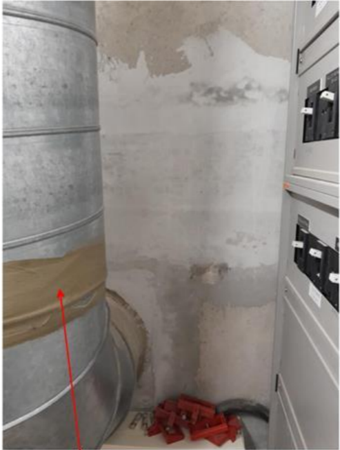
P72 : Conduit de fluide- Enduit étanchéité marron
