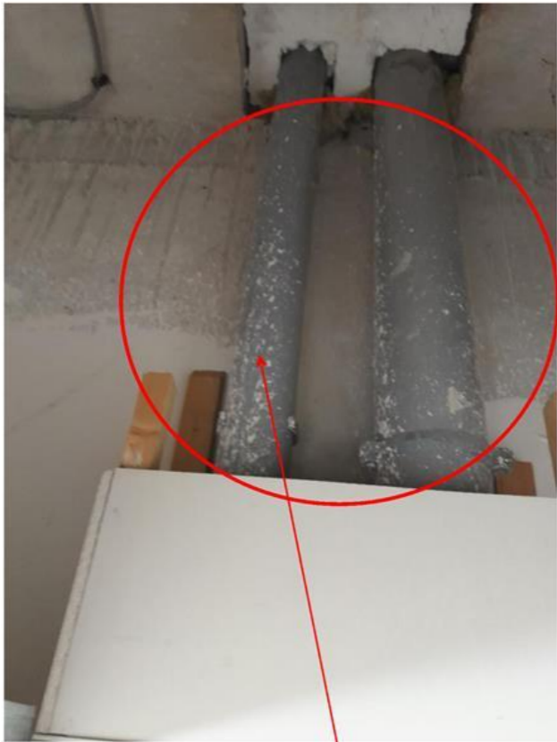
P36: enduit Plâtre projeté (plenum) Prélèvement de l'enduit directement sur le conduit PVC
