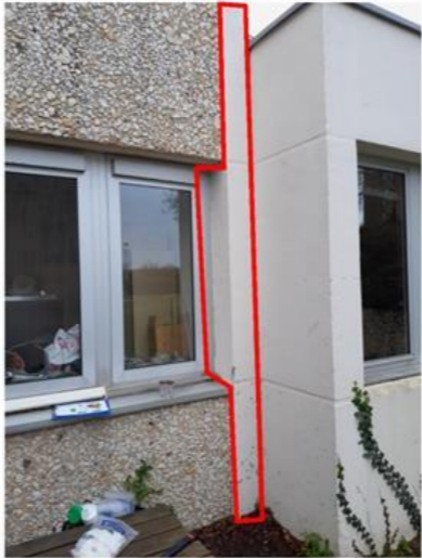
E21: Mur- Enduit ciment + peinture
